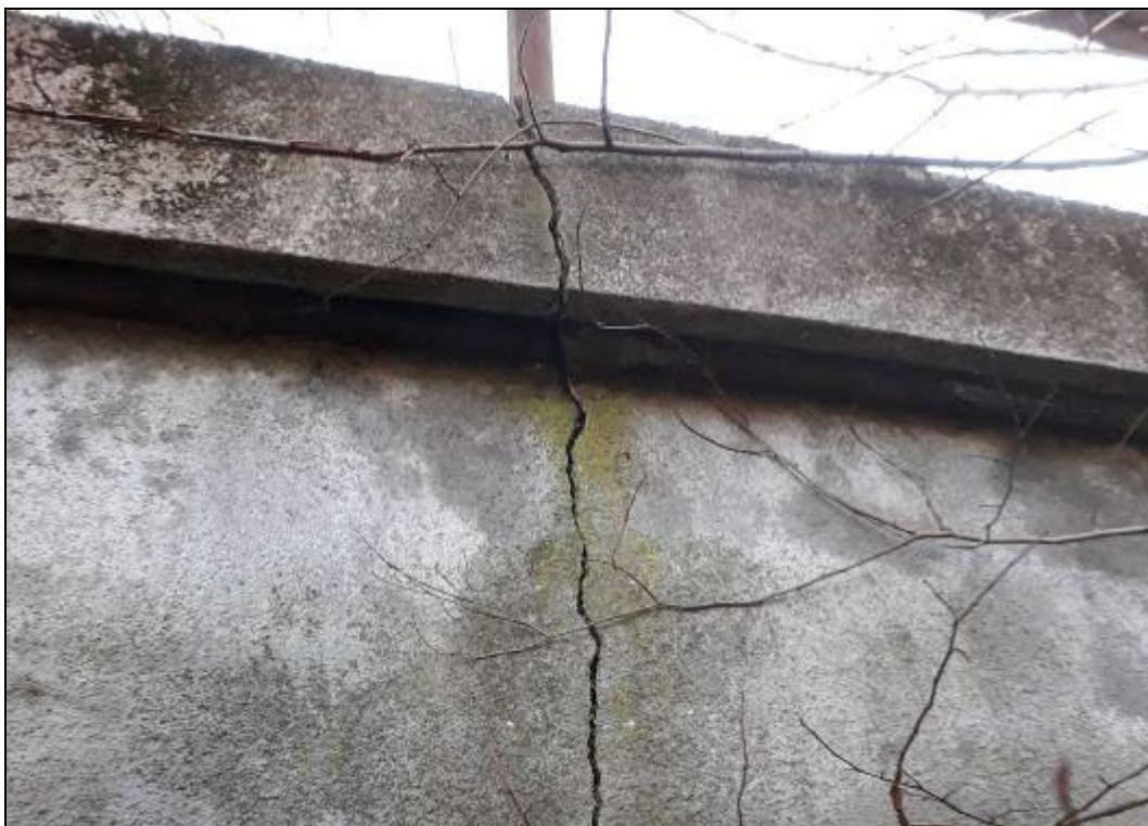
Obr. č. 12 - pohled na svislou trhlinu na levém čele přecházející do římsy
